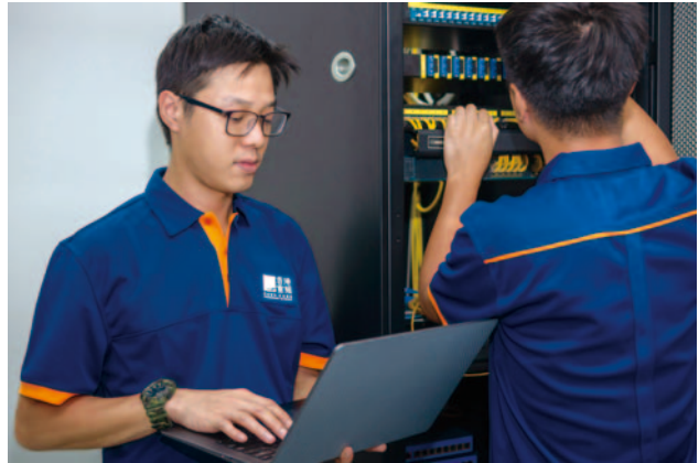
我們的服務工程師確保網絡及基礎設施是業內最頂尖的。
